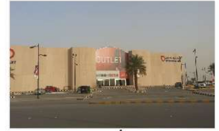
الرياض أوت ليت مول Riyadh Outlet Mall
