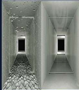
تنظيف مجاري الهواء Duct Cleaning
