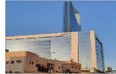
برج الجماز Al-Jamaz Tower
